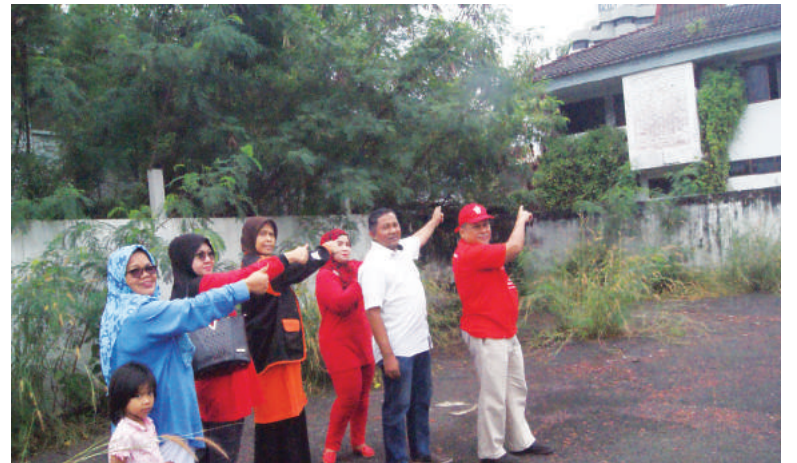
Para pemimpin PH negeri menunjukkan binaan KCC yang sudah ditumbuhi belukar.
