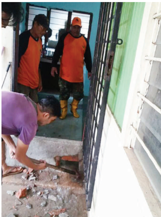
Anggota ARiF membaiki kerosakan yang berlaku di sebuah rumah penduduk setelah banjir surut.
